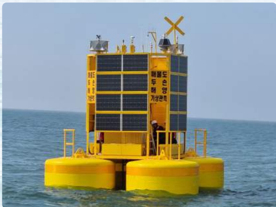
⑤ 해상 설치 완료(정면)
