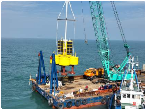
③ 해상 설치(표체 조공구 이용 설치)
